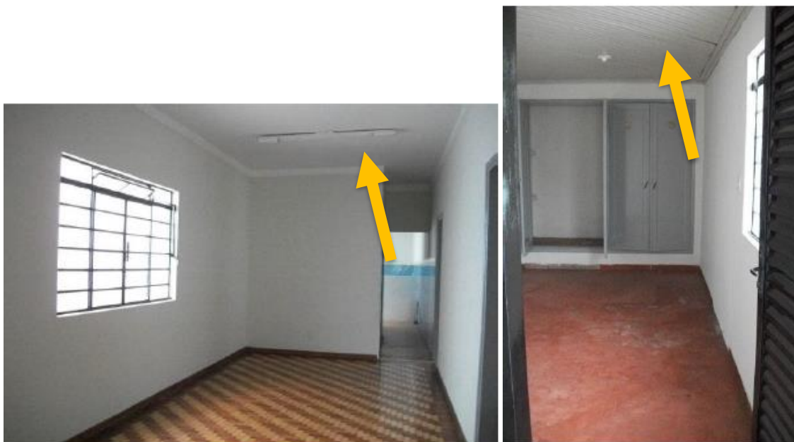
Figura 3- Acabamentos do teto (Fonte: Fotos Pré-Reforma)
