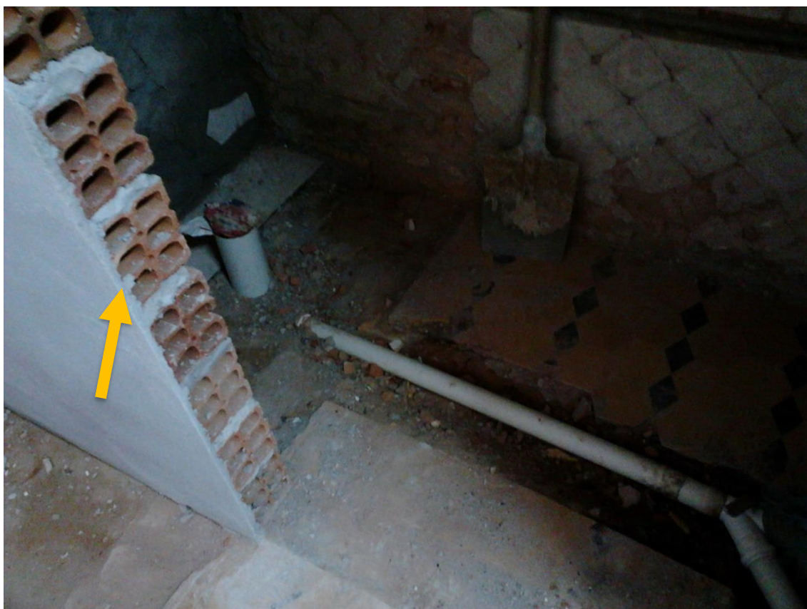
Figura 5 - Parede construída na reforma (Fonte: Fotos da Reforma)
