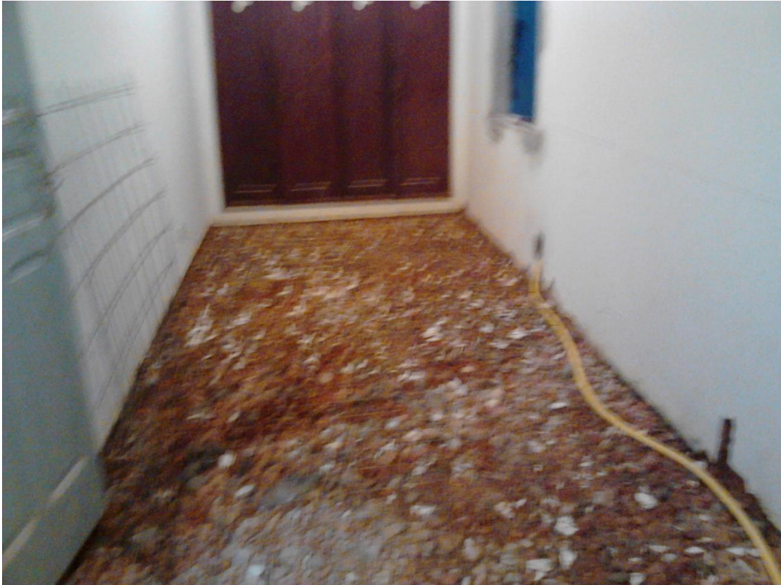
Figura 6 - Sala de Reunião sem piso (Fonte: Fotos da Reforma)
