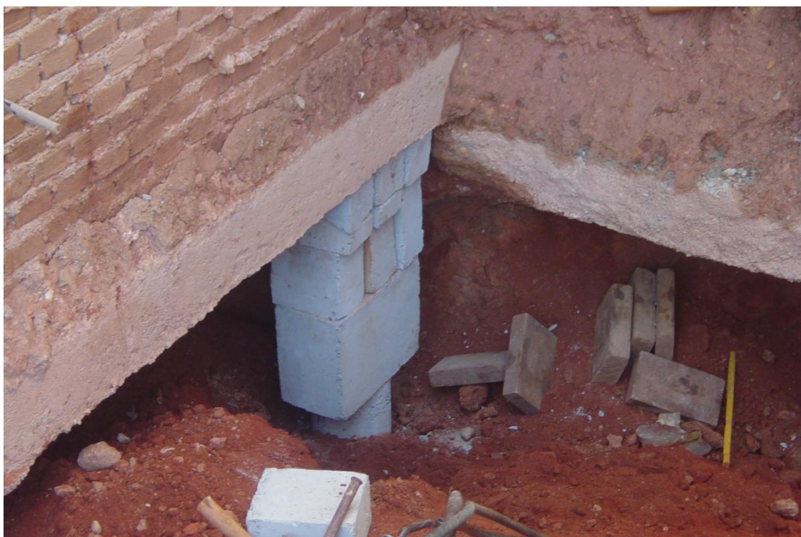
Figura 12 - Exemplo estaca mega (Fonte: https://megaconstrucoes.com.br/ )]
